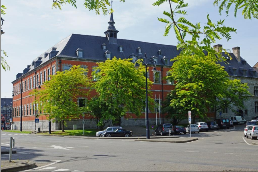
▲ Bâtiment actuel des XVI e et XVII e siècles, siège du Parlement wallon. Photo de l'auteur.
